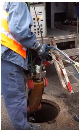
Figura 1 – Inserção do robô de inspeção
